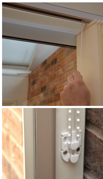
6. Træk alle lameller ind, så de er i låst position. Træk derefter knuden foran den første lamel ud, til linen er spændt ud i den underste stilling, som i det nederste billede.
