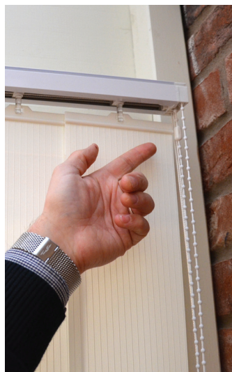
2. Træk i kæden, til kædelåsen sidder i toppen.
