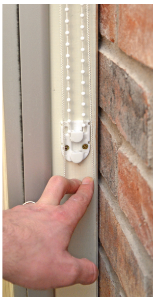
5. Fjern vægten fra snoren. Læg snoren i underste stilling.
