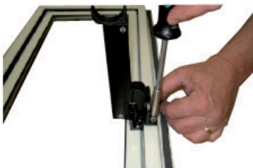
Aseta ikkuna alustalle sisäpuoli ylöspäin kuvan mukaisesti. Ruuvaa kahva kiinni karmiosaan ristipääruuvimeisselillä.
